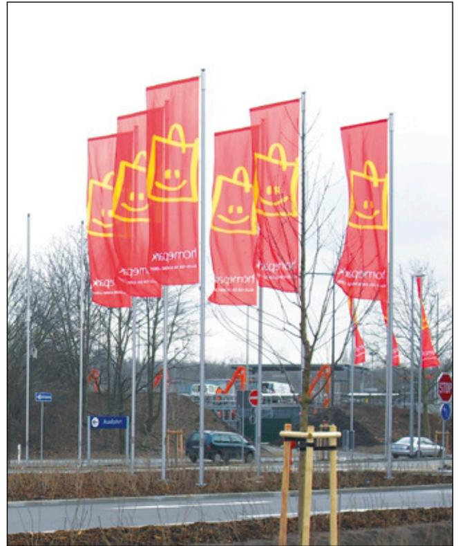
Sicherheitsmasten (12 mtr. über Boden) mit Kippgelenk
