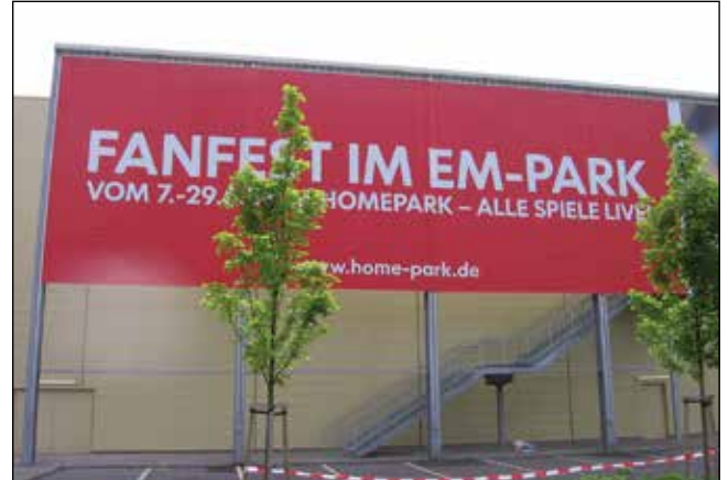
Liftersystem (34 x 7 mtr.) auf Stahlkonstruktion
